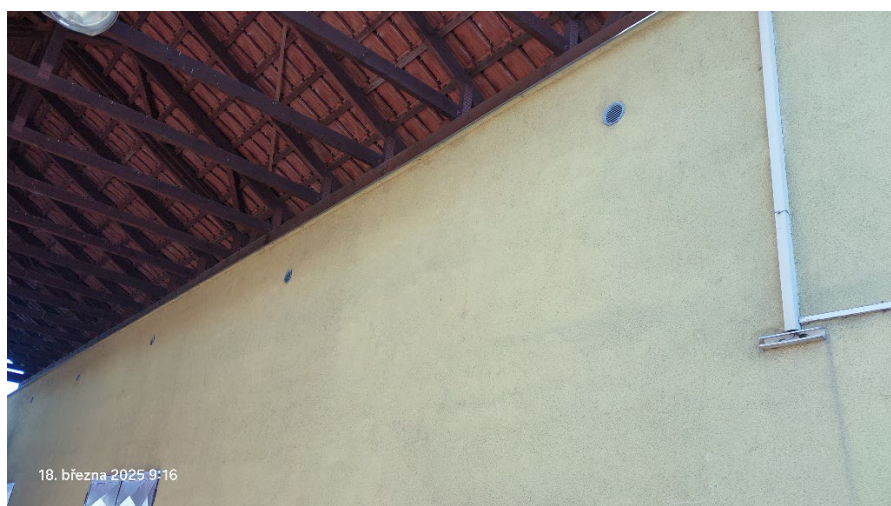
Obr. č.3 provětrávací otvory v atice jsou uzavřeny mřížkou.
