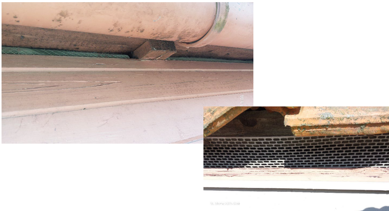
Obr. č.4 štěrbina v podstřeší je ve všech případech uzavřená, buď paropropustnou folií, nebo platovou mřížkou.
